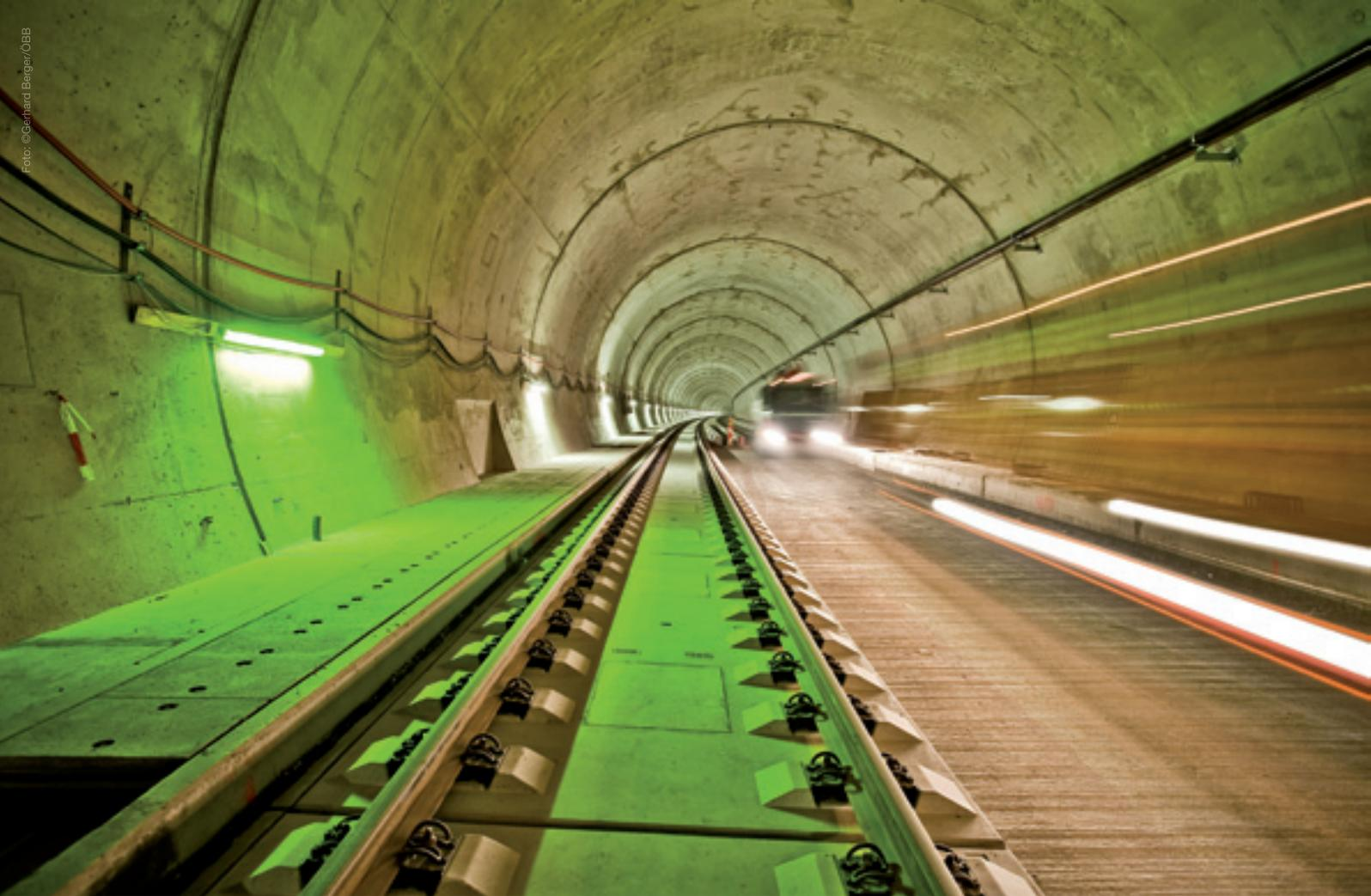
Der Tunnel während der Bauarbeiten zur Verlegung der Gleisanlagen
