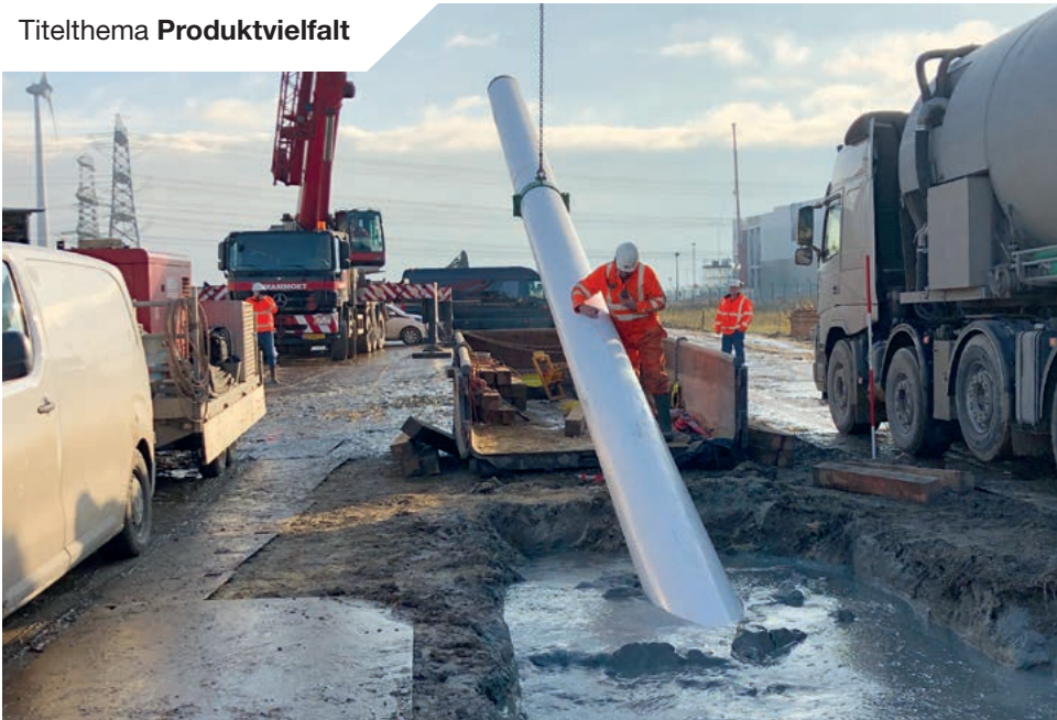
Die PP-umhüllten Rohre werden in die vorbereitete Grube geführt.
