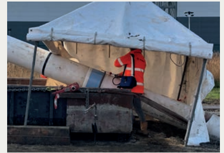
Oben: Prüfung der Nachumhüllung und der Schweißverbindung.
