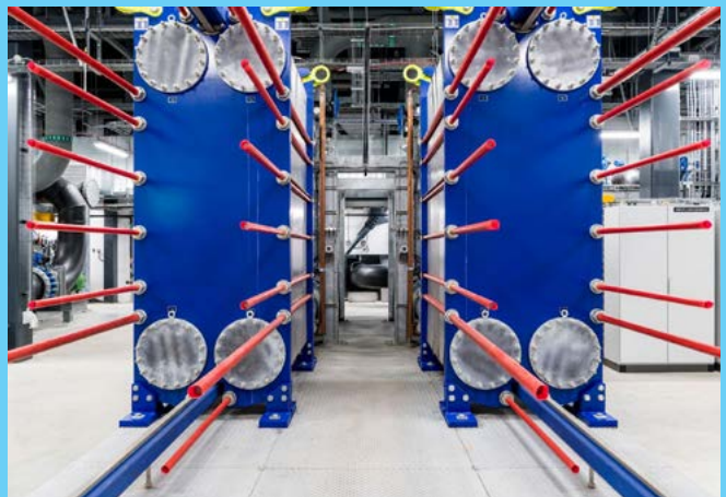
Bei der Kühlung des Rechenzentrums spielen Wärmetauscher eine wichtige Rolle. Foto: © Google
