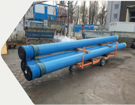
Per Handwagen wurden die 6 m langen Teilstücke durch die Aufzüge in die Tunnelröhre verbracht.
