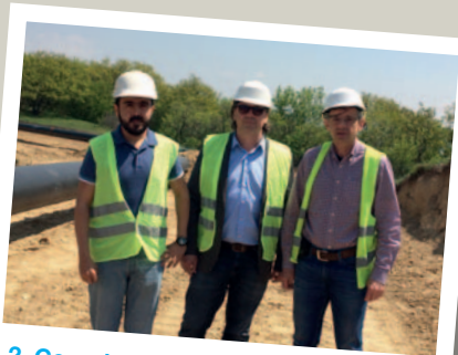
2. Georgien Rohrverlegung im Rahmen des »Sectional Replacement Project« der Western Route Export Pipeline (WREP).
