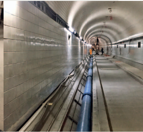
Ohne Schweißen konnte die insgesamt 426,5 m lange Leitung installiert werden.
