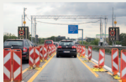
Die eingeschränkte Nutzung der »alten« Schiersteiner Brücke sorgte für kilometerlange Staus und großen Unmut bei allen Beteiligten.
