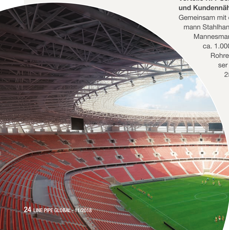
Links: Die HFI-geschweißten Rohre von Mannesmann Line Pipe übernehmen in der Dachkonstruktion des neuen Stadions eine tragende Rolle. Abbildung: ©www.mnsk.hu
