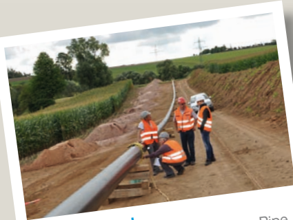
1. Deutschland Kerstin Becker, Mannesman Line Pipe, und Tino Flach (2.v.r.), Bauunternehmen Markgraf, begleiten die Rundnahmeprüfung an einer Soleleitung.
